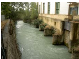
Central Hidroeléctrica del Salto del Lobo.
